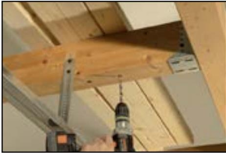
3. Zwei Deformationswinkel E Rücken an Rücken am UA Profil K mit zwei Schrauben M8 G und einer Kontraplatte F anschrauben (Schrauben noch nicht ganz festziehen).
