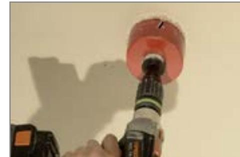
8. Deckenbeplankung (z.B. 2. Lage) anpassen, zentralen Punkt des Absorbers B einmessen und Öffnung mit Dosenbohrer ausschneiden.
