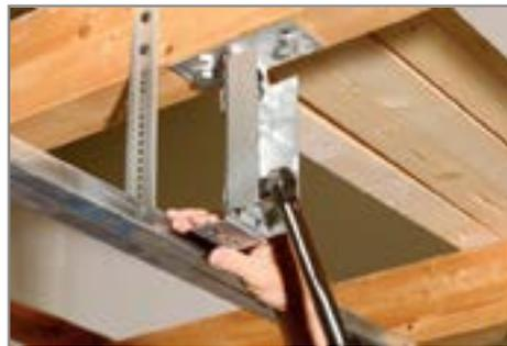
6. Absorber B am anderen Ende des UA Profils K mit zwei Schrauben M8 G und einer Kontraplatte F anschrauben (Schrauben G noch nicht festziehen, siehe Bild 3.1.)
