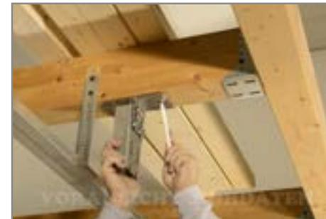
1. Die Position des Anschlagpunktes **A** an der tragenden Konstruktion anzeichnen. Bei Rasterdecken wird der Anschlagpunkt jeweils in Feldmitte einer MF oder HW Platte positioniert.
