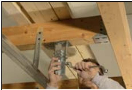
5. Deformationswinkel E mit zwei Stk. Sechskant Holzschrauben 12/100 I inkl. Beilagscheiben J an der tragenden Konstruktion festschrauben
