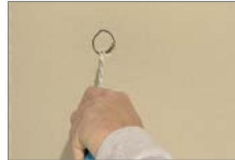
7. Ggf. zuerst an eingemessener Position etwa münzengroßes Loch ausschneiden und Dosenbohrer an der zentralen Bohrung des Absorbers B ausrichten und die Dosenöffnung kreisrund ausschneiden. Deckenbeplankung befestigen und spachteln, bzw. Akustikplatte einsetzen.
